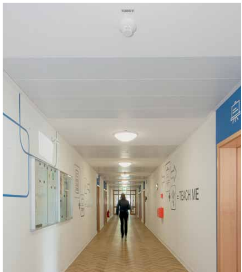
Die Nutzung von Fluchtwegen kann je nach Alarmfall Risiko oder Rettung bedeuten.
