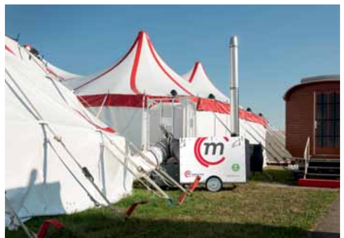
Heizmobile können auch mit Pellets betrieben werden, wie hier bei einem Event.
