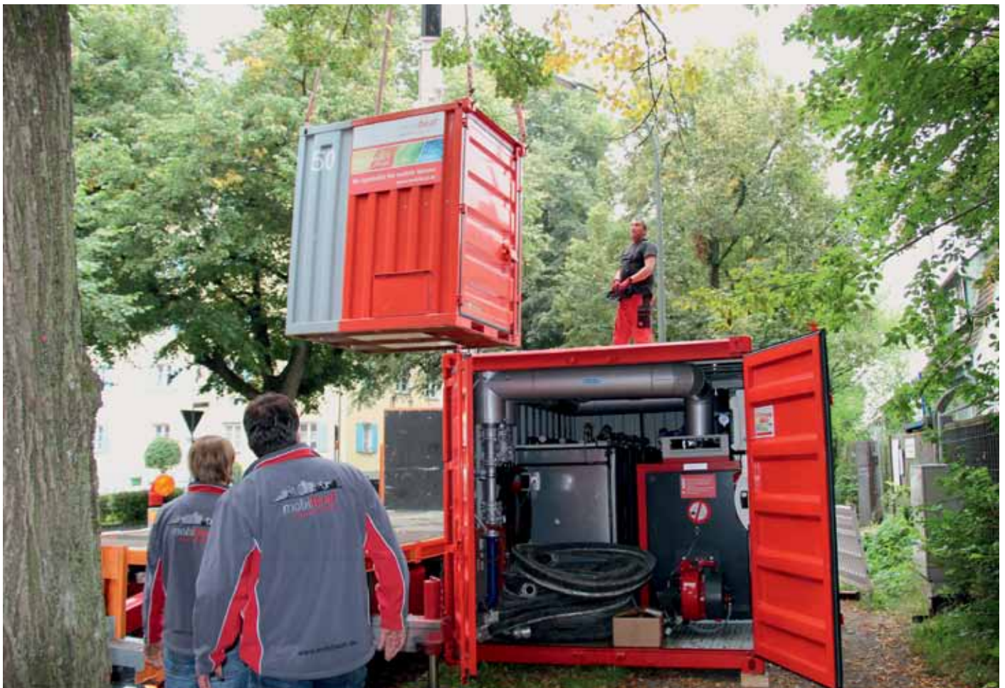
Installation einer mobilen Heizanlage als Fernwärmeersatz während Wartungsarbeiten in Augsburg
