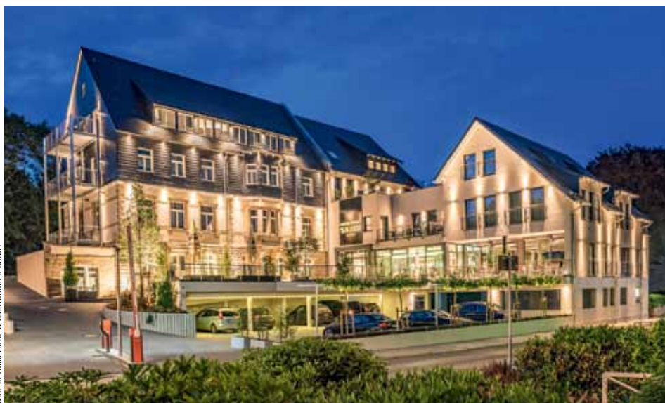
Der mit polyvalenter Wärmepumpe klimatisierte Gebäudekomplex
