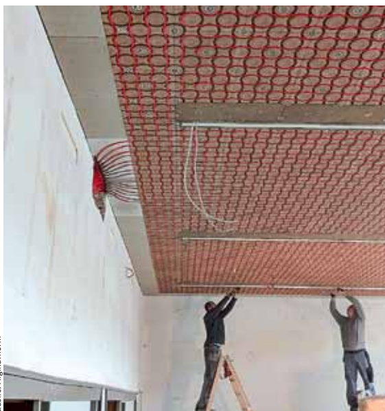
Montage der Natur-Klimadecke mit integriertem Schall-Ringabsorber und HochLeistungs-Rohrverteilmol.
