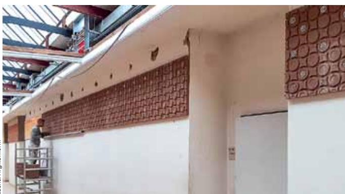
Die HochLeistungsLehm-Module sind auch als Wandheizung einsetzbar.
