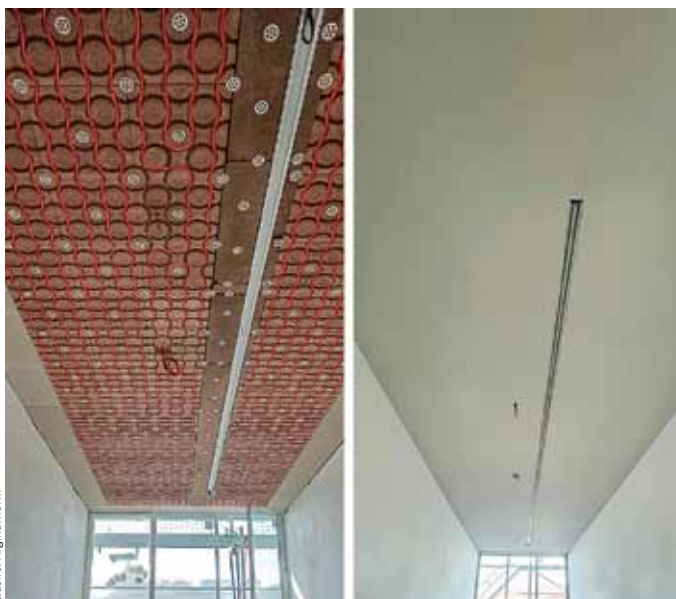
HochLeistungsLehm-Module mit Schall-Ringabsorber und integrierter Lichtschiene vor und nach Beschichtung.
