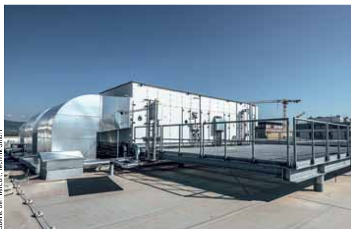
Quelle: BerlinerLuft, Technik GmbH
