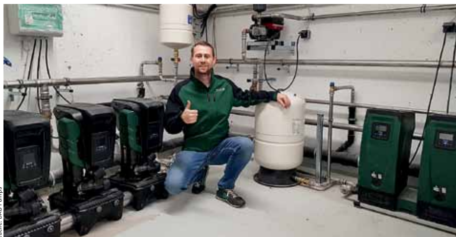
Druckerhöhung auf 6 bar mit drei Pumpen DAB Eskybox Max 60/120 T, effiziente Pumpenkraft, Daumen hoch von Sven Juran (DAB Gebietsverkaufsleiter Berlin/BRB)
