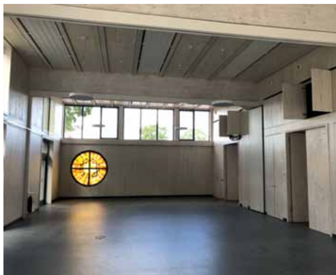
Das im Gemeindesaal integrierte Lüftungssystem sorgt für angenehme Belüftung.
