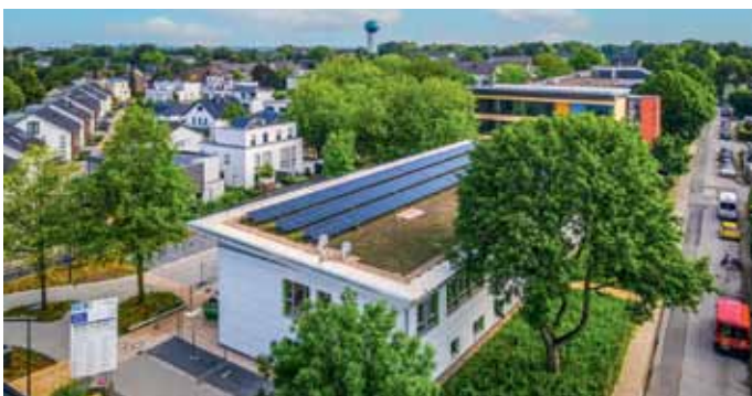
Schulbau als Passivhaus. Die PV-Anlage auf dem Dach ist ein wichtiger Bestandteil zu Erlangung des Passivhaus-Standards.
