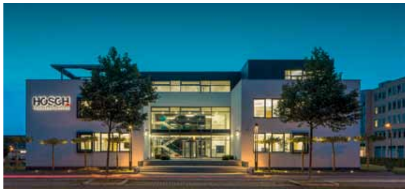
Die HOSCH Firmenzentrale in Teltow wurde von der eu-bac mit A+ bewertet und ist damit eines der innovativsten Bürogebäude Europas.
