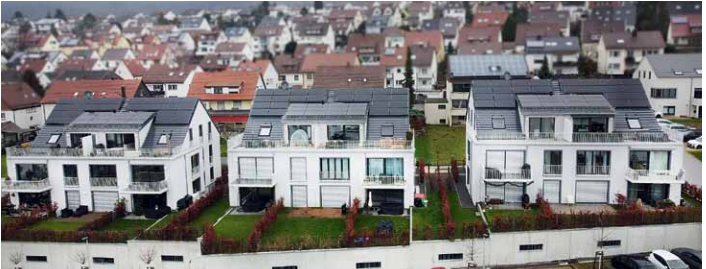
In Altbach bei Stuttgart werden drei Mehrfamilienhäuser jeweils über eine PVT-Wärmepumpen-Anlage mit Wärme versorgt. Pro Haus besteht diese aus 36 PVT-Kollektoren mit einer Gesamtfläche von je 71 m 2 und zwei Wärmepumpen mit je 14 kW Leistung.
