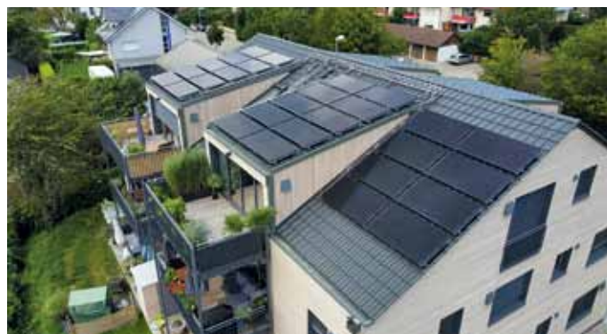
Nach Teilrückbau und Wiederaufstockung eines Mehrfamilienhauses in Heitersheim bei Freiburg versorgt die PVT-Wärmepumpenanlage seit Dezember 2020 sechs Wohnungen mit einer Gesamtfläche von 560 m 2 .
