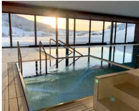
Das Schwimmbad (mit 2 Saunen) wird von der Wärmepumpe mit 35 °C ganzjährig geheizt.
