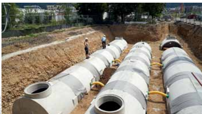
Sickeranlage Nord mit drei Rigolensträngen. Nach Versetzen der Sickertunnel und vor Verfüllen der Baugrube werden die Fugen zwischen den Elementen mit Geotextil abgedeckt, die Domschächte bis zur Geländehöhe aufgesetzt und Verbindungsleitungen zwischen den Rigolen verlegt.
