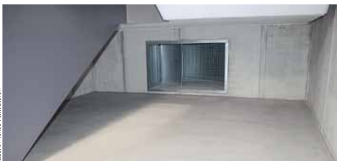
Einblasstelle Zuluft im Untergeschoss
