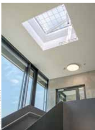
Automatisch geöffnete Lichtkuppel an oberster Stelle des Sicherheitstreppenraums
