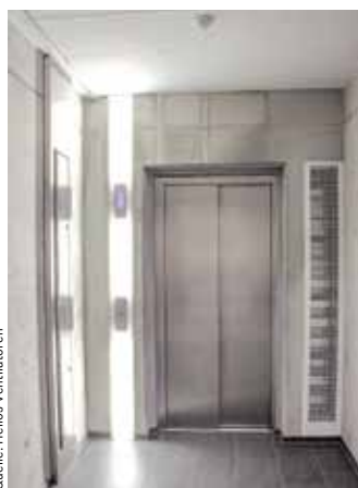
Feuerwehraufzug mit motorisch betriebener Überströmöffnung zum Vorraum
