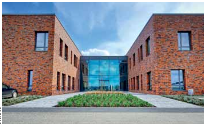
Das neue Bürogebäude von TKS in Borken schafft Platz für das geplante Wachstum des Unternehmens.
