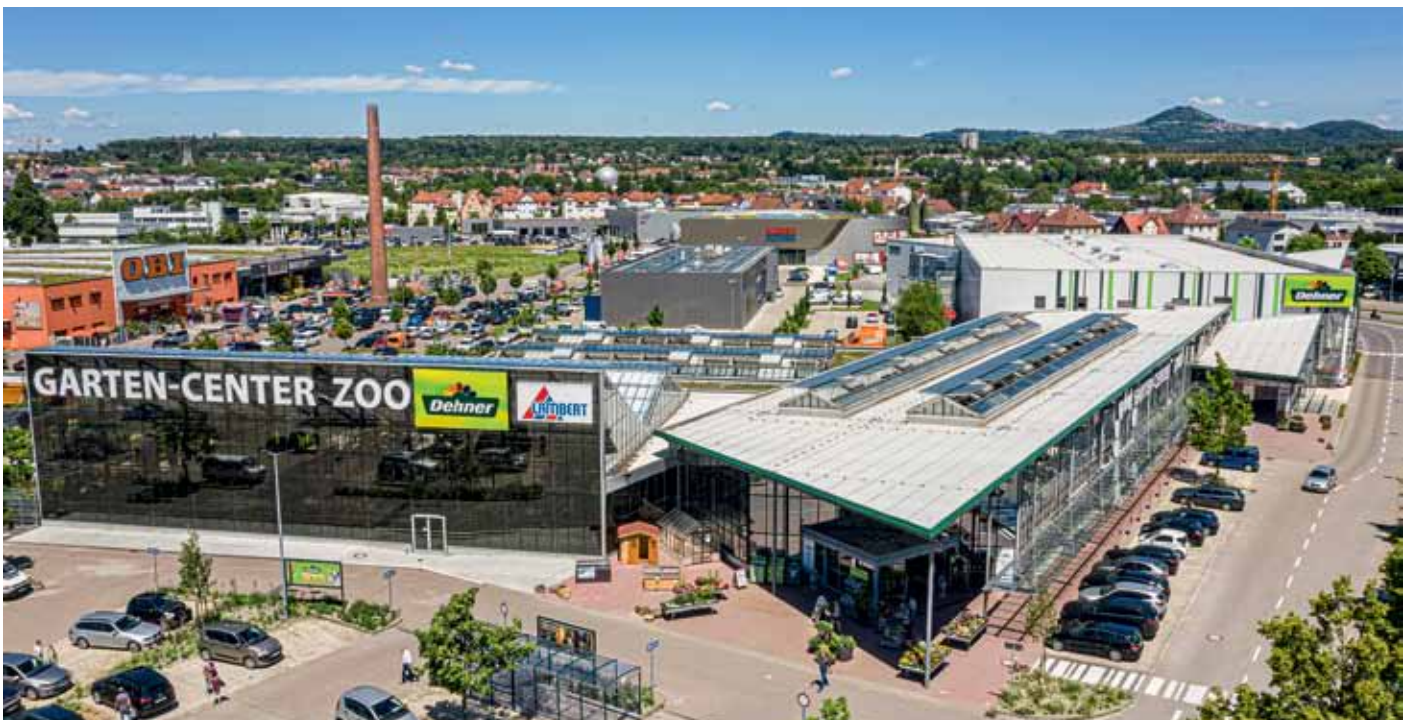
Das neue Dehner Garten-Center in Göppingen mit rund 6.000 m 2 Verkaufsfläche.
