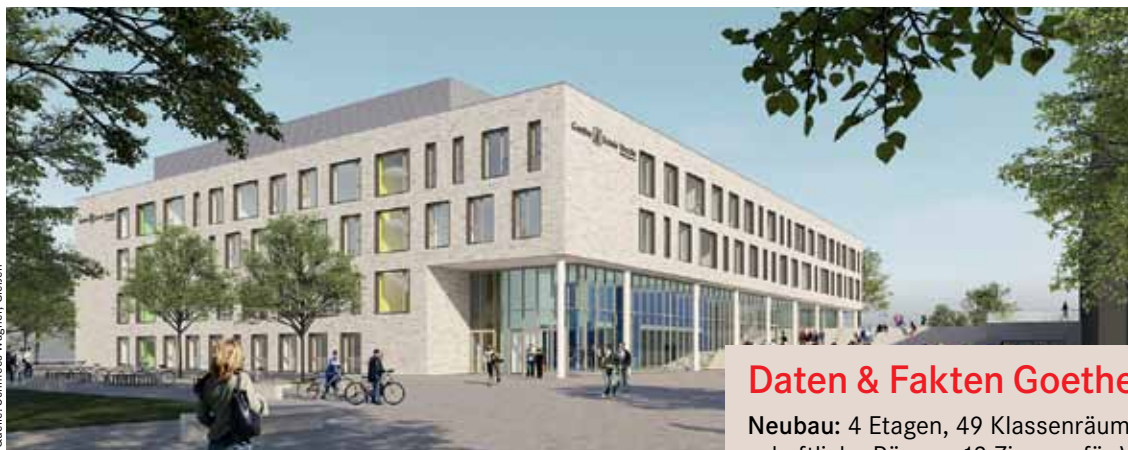
Die Goetheschule in Wetzlar wird neu gebaut. Der Einzug soll noch im Sommer stattfinden.
