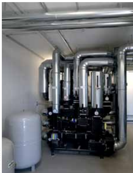
Mit dem Hydraulikmodul unterstützt Buderus die Handwerkspartner bei der hydraulischen Installation.
