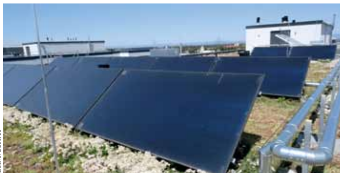
Solarthermieanlagen auf jedem Gebäudedach mit jeweils 50 Logasol Hochleistungs-Flachkollektormodulen unterstützen Heizung und Trinkwassererwärmung.
