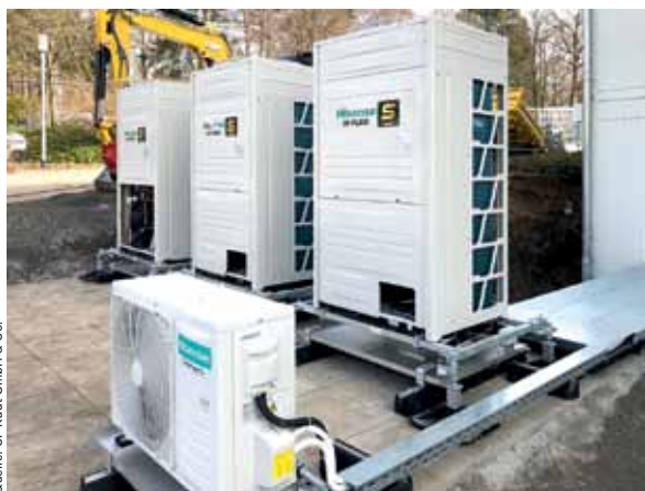
Bodenmontage der PAC- und VRF-Außeneinheiten
