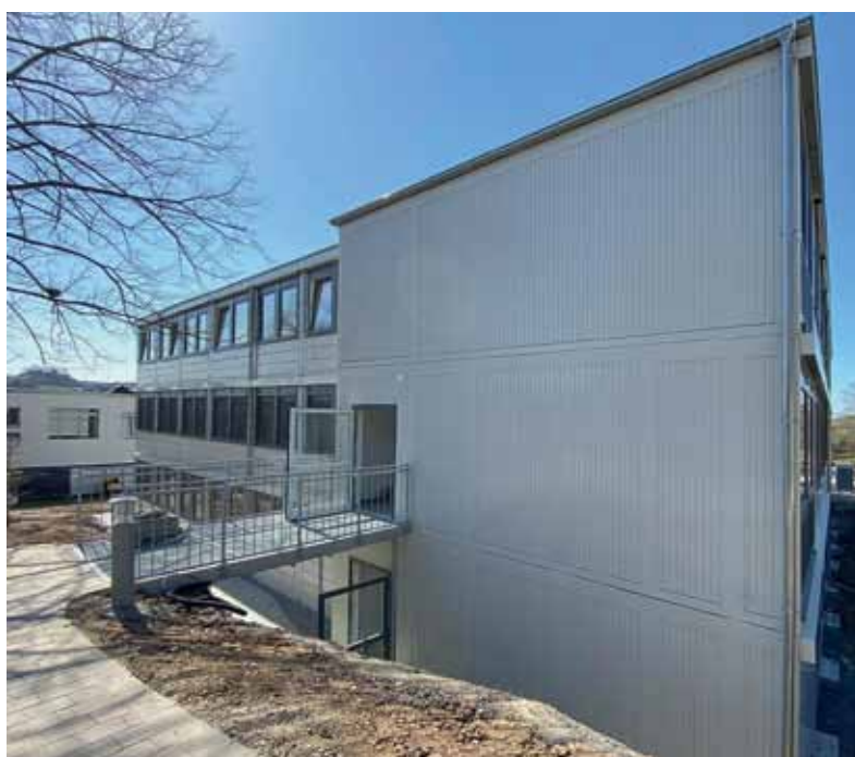
Modulraumgebäude der Fachklinik in Weinsberg
