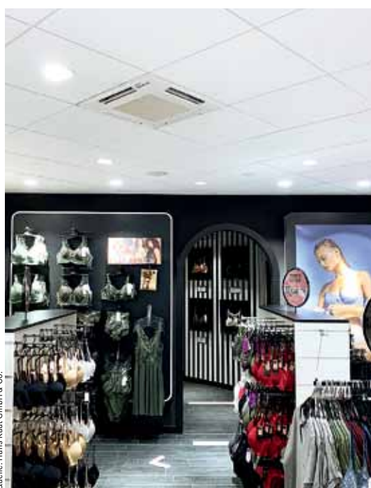
Nahtlose Integration der Inneneinheiten in die Odenwalddecken
