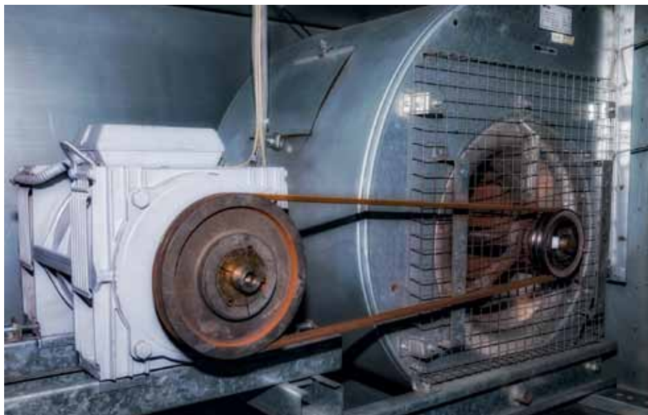
Alte Lüfter werden mit einem Riemen angetrieben.
