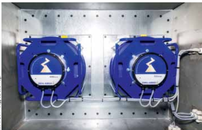
Ziehl-Abegg Ventilatoren werden direkt angetrieben, ganz ohne Riemen.
