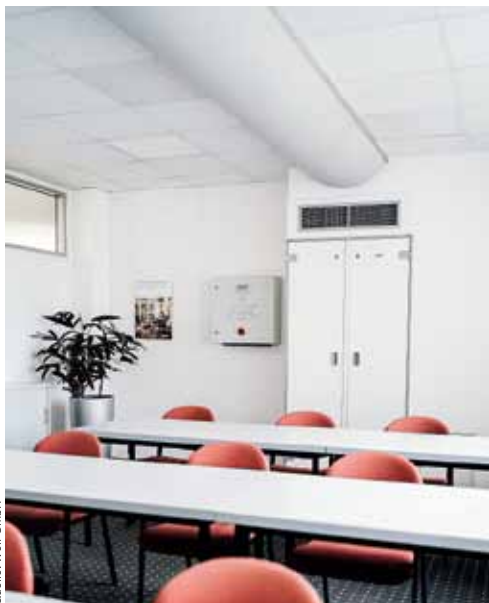
Das Comfort Großraum-Lüftungsgerät (CGL) hier mit Luftverteilung über textile Schläuche. Der Lufteintrag in den Raum erfolgt turbulenzarm nach dem Prinzip der Quelllüftung.
