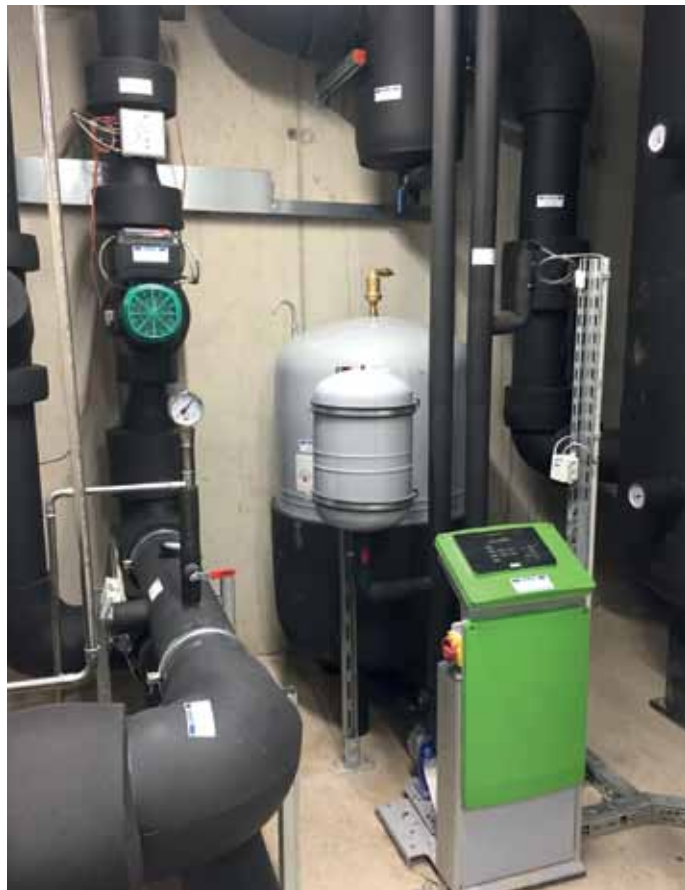
1 × Variomat VS 2-1-60 mit VG 500, oben ein isolierter ExdirtDN150 mit Exferro
