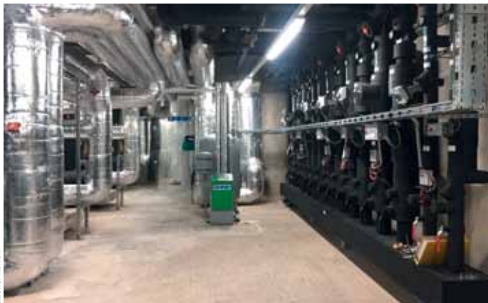
1 × Variomat VS 2-1-60 mit VG 600, Verteilertechnik SINUS
