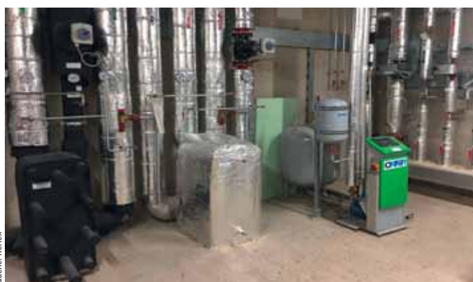
1 × Variomat VS 2-2-60 mit VG 200, im Hintergrund Verteilertechnik von SINUS
