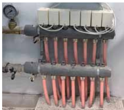
SK-Stellantriebe am Heizkreisverteiler der Fußbodenheizung
