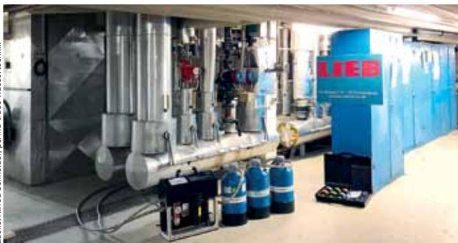
Jeweils drei Entmineralisierungseinheiten lassen sich gleichzeitig in Reihe schalten und sorgen dafür, dass neben Härtebildnern wie Magnesium und Calcium auch korrosive Salze wie Chlorid und Sulfat entfernt werden. Im Gegensatz zu einer Enthärtung hat das Wasser nach der Entmineralisierung eine stark reduzierte elektrische Leitfähigkeit.
