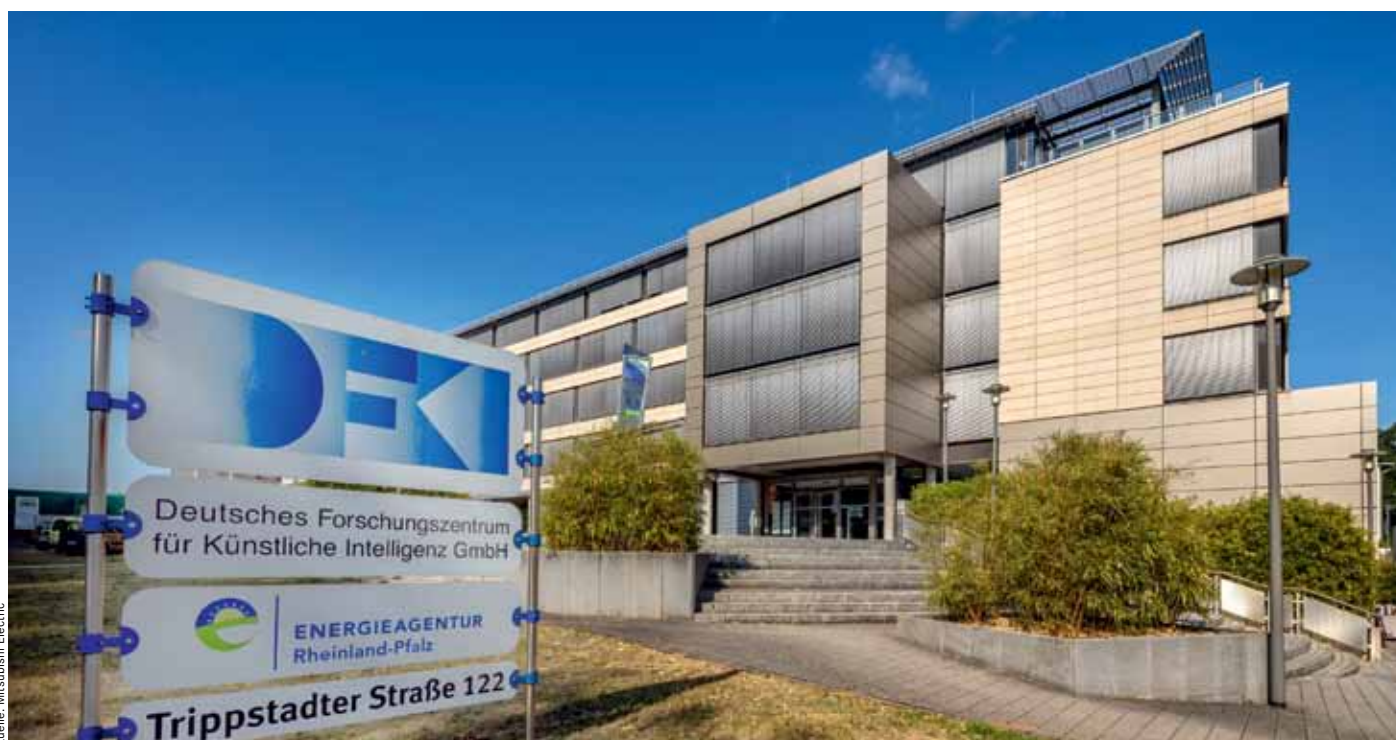
Quelle: Mitsubishi Electric
