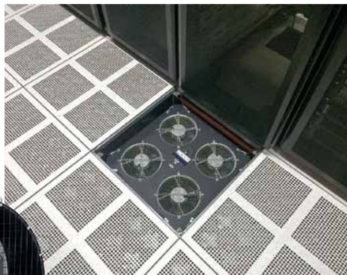
3 – Aktive Bodenfliesen führen die kalte Luft aus dem Unterboden zielgerichtet an die Stellen, an denen sie benötigt wird.
