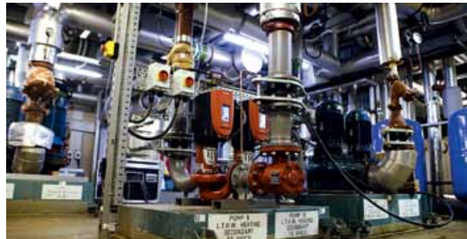
Bei National Grid installierte und betriebsbereite Armstrong Design Envelope Tango Pumpe inklusive der werkseitig vormontierten Rohrleitungen
