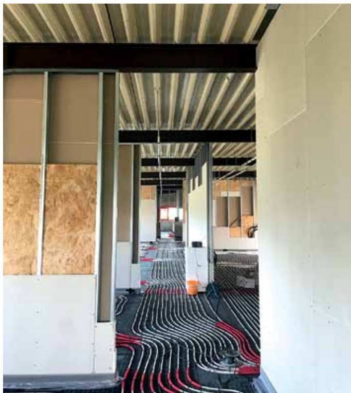
Die rund 750 m 2 große Bürofläche wird über eine Fußbodenheizung geheizt.
