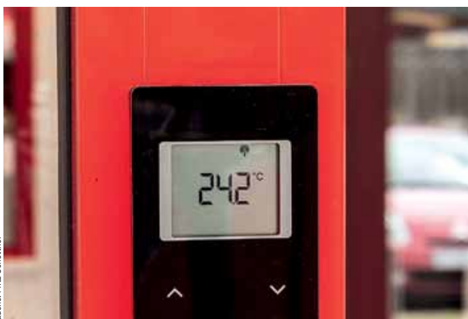
Über das Funk-Regelungssystem EnergyLogic Touchline kann der Heiz- oder Kühlfall getrennt gesteuert werden.
