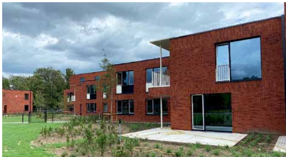
Das OPZ (Psychiatrisches Zentrum) in der Stadt Geel wurde um fünf Gebäude und 80 Wohneinheiten erweitert.
