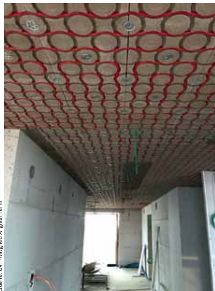
Montage der Lehmmodule auf einer Unterkonstruktion direkt an der Decke
