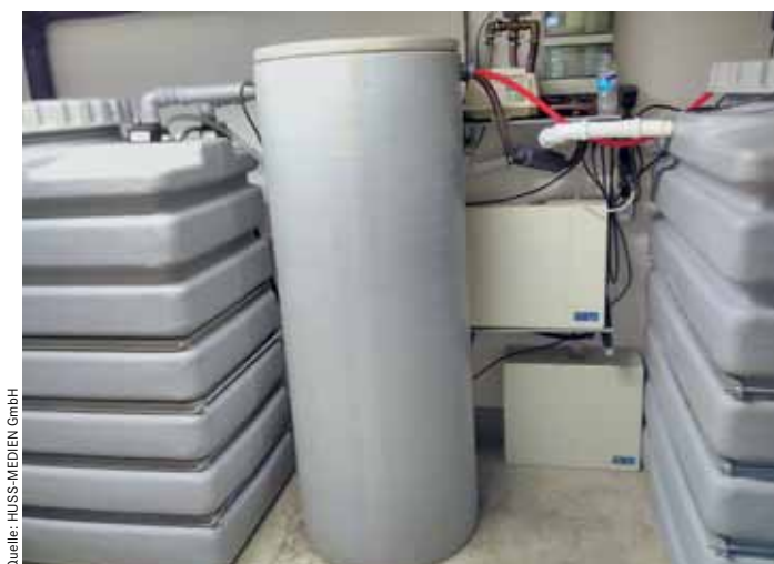
Grauwasseraufbereitung im Kellergeschoss des Passivhauses: Sammel-tank, Membrantank und Klarwassertank aus Kunststoff
