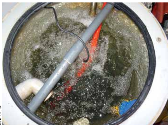
Membrantank mit Belüftung
