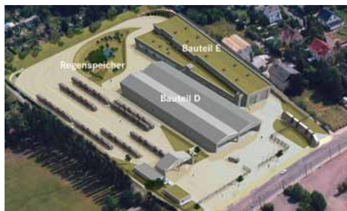
Umbau des Straßenbahnbetriebshofs in Leipzig-Dölitz Mittig vorhandene Betonhalle (Bauteil D, Bitumendach), rechts oben Neubau Wasch- und Wartungshalle (Bauteil E, extensiv begrüntes Solardach), links oben Retentionsfläche mit unterirdischem Regenspeicher.
