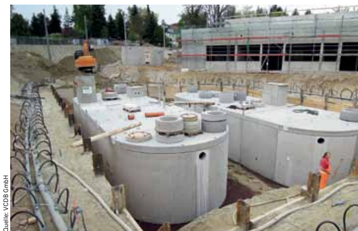
Unterirdische Speicherbehälter aus Betonfertigteilen – links 250 m 3 für das nutzbare Regenwasser, rechts 250 m 3 als Regenrückhaltebecken.
