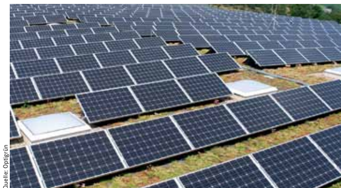
Extensiv begrüntes Solardach auf Bauteil E, dem Erweiterungsbau mit Wasch- und Wartungshalle. Ablaufendes Regenwasser wird für Gleispflegefahrzeuge und Grünanlagenpflege genutzt.
