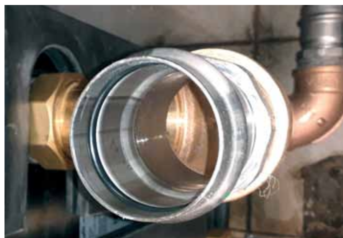
1 – Pressfitting DN 50 vor dem Verbauen – deutlich sichtbar sind der O-Ring in seiner Führungssicke und der wasserseitige Anschlag für das einzusteckende Rohr.
