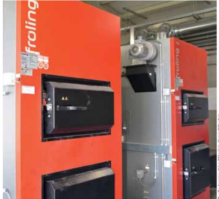
den beiden Quer- und Steilförderschnecken (Bild 4) die Austragung des Hackguts aus dem ca. 200 m<sup>3</sup> großem Lager in den Feuerungsraum der Wärmeerzeuger. Minimaler Wartungs- und Reinigungsaufwand ergibt sich durch die Abgasrezirkulation mit den konstruktiv optimal angeordneten stehenden Wärmetauschern und automatischer Abreinigung. Die Einhaltung der gesetzlich normativen Auflagen wird durch die beiden nachgeschalteten Elektrofilter mit einem Abscheidegrad von bis zu 85 % sichergestellt.
