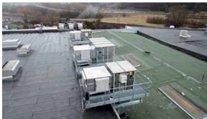
Die Lösung war eine Mischung aus adiabatischem Kühlsystem und einer Be- und Entlüftungsanlage.
