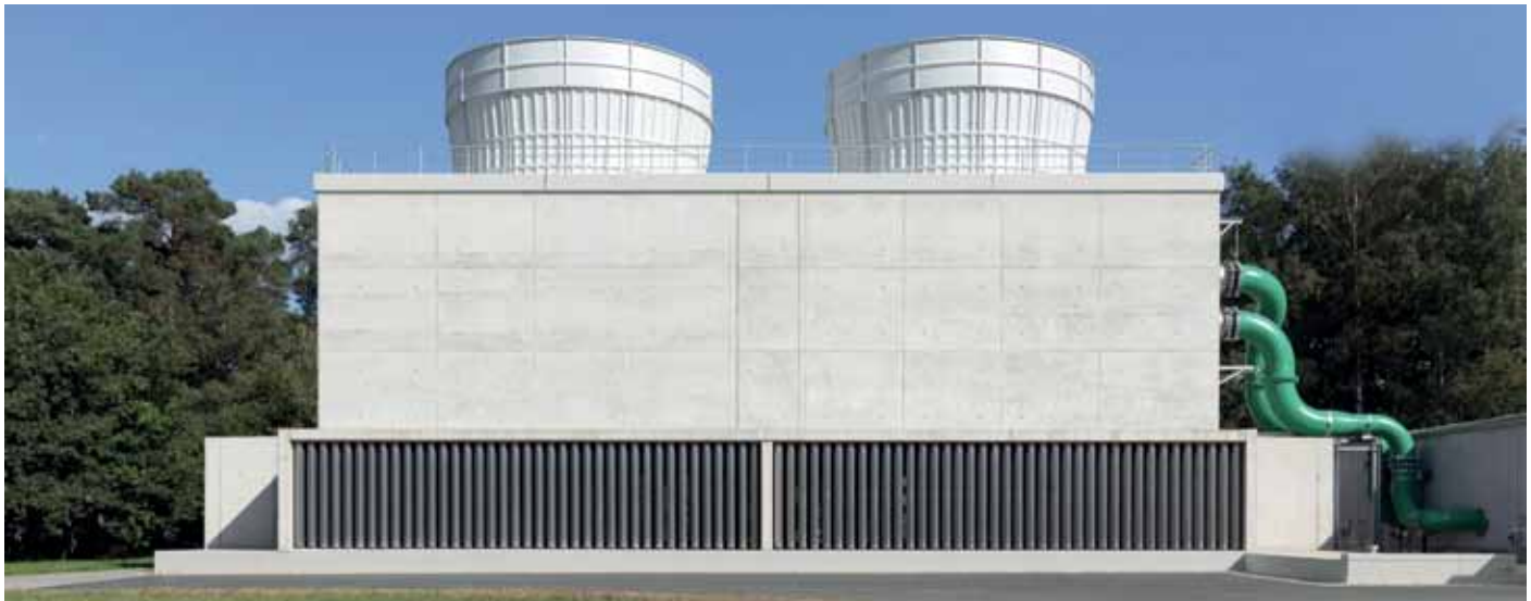
Für die neuen Kühltürme des Deutschen Zentrums für Luft- und Raumfahrt (DLR) in Köln erbrachte pbr die Technikplanung.
