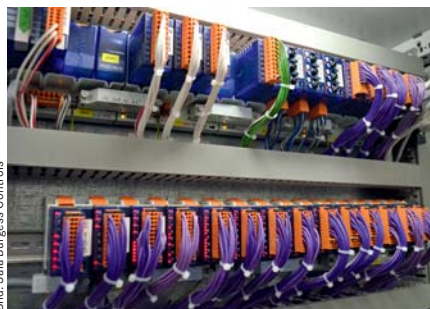
Eine der 12 Steuerungen vom Typ PCD3 mit Interfacebausteinen
