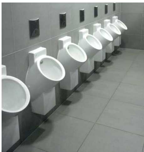
Das Wassermanagementsystem A3000 open ermöglicht z. B. regelmäßige Hygiene- spülungen der PROTRONIC Urinalspüler.
