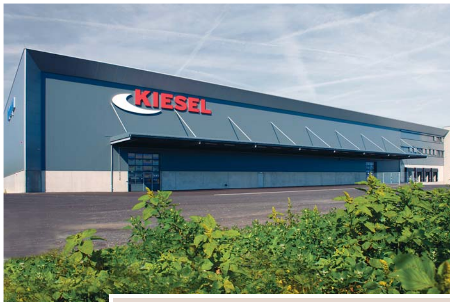
1 – Das 10.000 m 2 große Logistikzentrum der Kiesel GmbH
