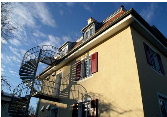
Auf der Rückseite der „Alten Villa“ fallen Außenluft- und Fortluftanschluss hinter der Feuerterppe kaum auf.
