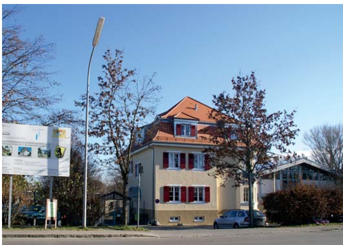
Die beiden Gebäude der evangelischen Tagesstätte Grafing wurden energetisch modernisiert und mit LTM-Lüftungsgeräten mit Wärmerückgewinnung ausgestattet.
