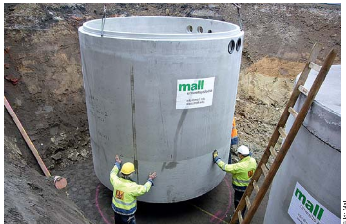
Einbau der beiden Pufferspeicher ThermoSol, Claudiushöfe in Bochum
