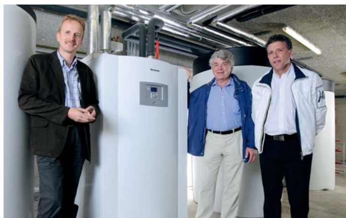
Das Herzstück des Wärmekonzepts ist die Wärmepumpe T 600 von Junkers. Im Bild von links: Junkers-Mitarbeiter Jörg Vorländer, Projektmanager Frank Sagenschneider und Installateur Alexander Mandara
