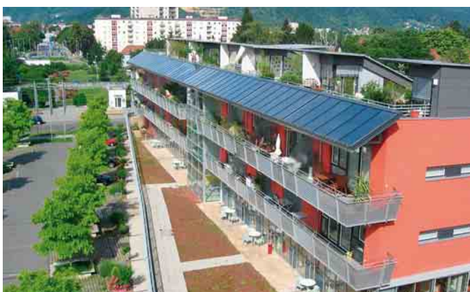
Solarthermische Anlage auf einem Mehrfamilienhaus in Süddeutschland
